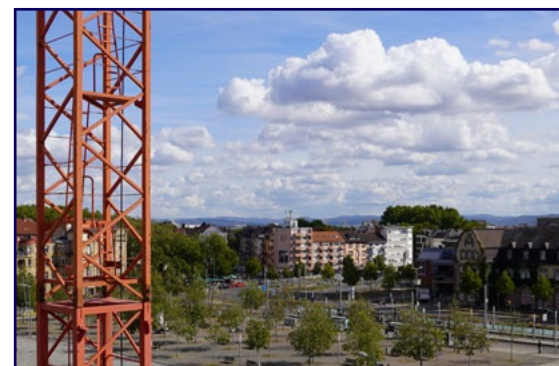
Blick vom Dach (Höhe der späteren Dachterrasse) des Forums Deutsche Sprache auf den Alten Meßplatz, © IDS/T.Schned. (aufgenommen 17.9.26)
