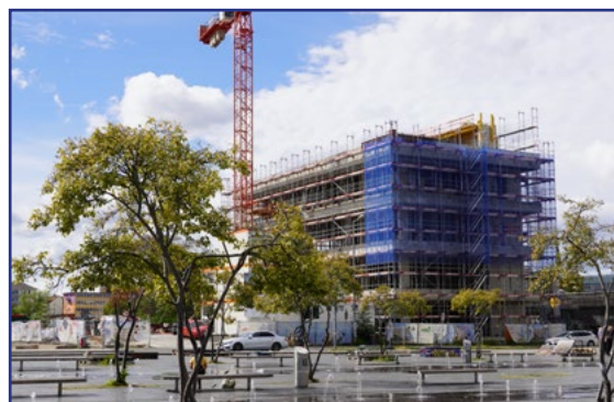
Blick auf den Rohbau des Forums Deutsche Sprache vom Alten Meßplatz aus, © IDS/T. Schned. (aufgenommen 17.9.26)
